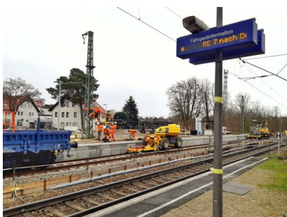
An den durchgehenden Hauptgleisen im Bahnhof Wünsdorf-Waldstadt werden vier Außenbahnsteige mit einer Breite von vier Metern errichtet (Februar 2022) [Quelle: DB Netz AG]
