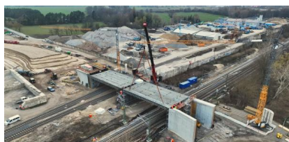
YouTube: Einhub der Brückenelemente für die Straßenüberführung der Bundesstraße B 246 in Zossen (März 2024) [Quelle: DB InfraGO AG]
