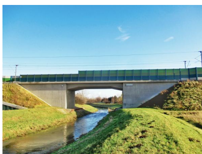
Die Lärmschutzwand in Großenhain wurde Ende 2021 fertiggestellt (Dezember 2021) [Quelle: DB Netz AG]
