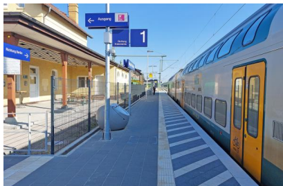
Blick auf den fertiggestellten Bahnsteig am Gleis 1 am Bahnhof Wünsdorf-Waldstadt (August 2023) [Quelle: DB Netz AG]
