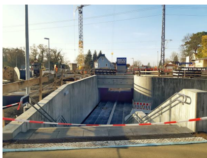
Die Personenunterführung im Bahnhof Wünsdorf-Waldstadt wurde im November 2021 eröffnet. Die östliche Rampe kann bereits mit dem provisorisch verschwenkten Gehweg genutzt werden (November 2021) [Quelle: DB Netz AG]
