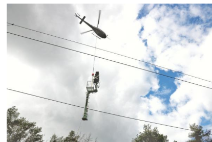
Die Signale wurden mittels Helikopter in Wünsdorf-Waldstadt aufgestellt (März 2021) (März 2021) [Quelle: DB Netz AG]
