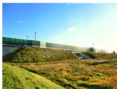
Die Lärmschutzwand in Großenhain wurde Ende 2021 fertiggestellt (Dezember 2021) [Quelle: DB Netz AG]
