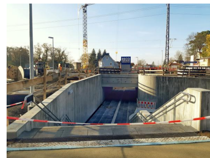
Die Personenunterführung im Bahnhof Wünsdorf-Waldstadt wurde im November 2021 eröffnet. Die östliche Rampe kann bereits mit dem provisorisch verschwenkten Gehweg genutzt werden (November 2021) [Quelle: DB Netz AG]
