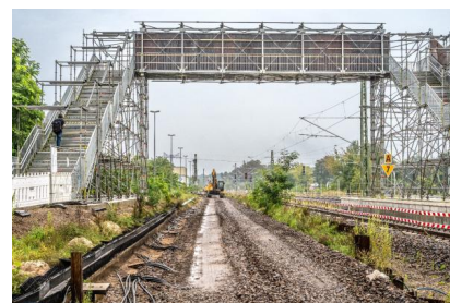
Blick auf die Baustelle für den Umbau des Bahnhofs Zossen (September 2025) [Quelle: PUS GmbH]
