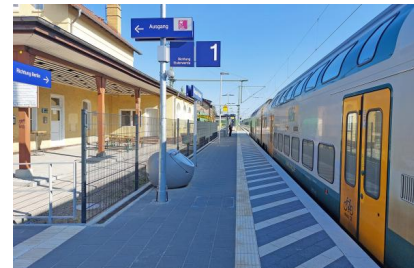
Blick auf den fertiggestellten Bahnsteig am Gleis 1 am Bahnhof Wünsdorf-Waldstadt (August 2023) [Quelle: DB Netz AG]
