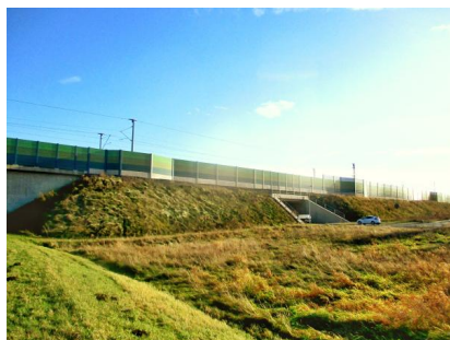
Die Lärmschutzwand in Großenhain wurde Ende 2021 fertiggestellt (Dezember 2021) [Quelle: DB Netz AG]
