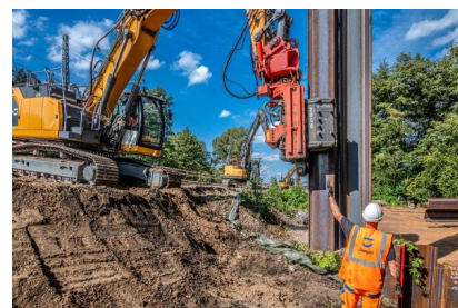
Blick auf den Spundwandverbau an Gleis 2 am Bahnhof Zossen (September 2025) [Quelle: PUS GmbH]
