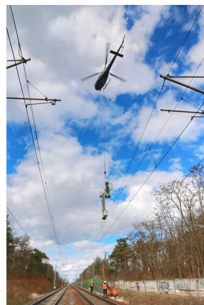
Am Bahnhof Wünsdorf-Waldstadt haben wir Signale mittels Helikopter gesetzt (März 2021) [Quelle: DB Netz AG]
