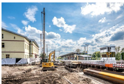
Rückbauarbeiten am Hausbahnsteig am Bahnhof Zossen (September 2025) [Quelle: PUS GmbH]
