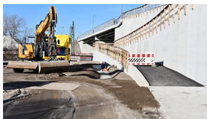
An der neuen Straßenüberführung der Bundesstraße B 246n in Zossen errichten wir eine Rampe (März 2025) [Quelle: PUS GmbH]
