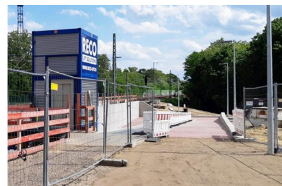
Die Rampe im Bahnhof Wünsdorf-Waldstadt kann seit dem 31. Mai 2022 befahren werden. Der bauzeitliche Personenaufzug wurde entfernt (Mai 2022) [Quelle: DB Netz AG]
