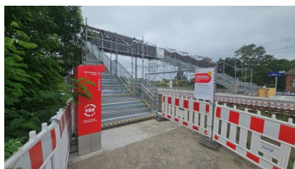
Provisorische Personenbrücke am Bahnhof Zossen (September 2025) [Quelle: PUS GmbH]
