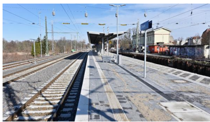
Blick auf den neuen Mittelbahnsteig am Bahnhof Zossen (März 2025) [Quelle: PUS GmbH]
