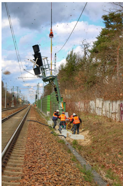
Das Aufstellen weiterer Signale in Wünsdorf-Waldstadt folgte bis zum 7. März 2022 (März 2021) [Quelle: DB Netz AG]
