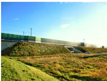
Die Lärmschutzwand in Großenhain wurde Ende 2021 fertiggestellt (Dezember 2021) [Quelle: DB Netz AG]
