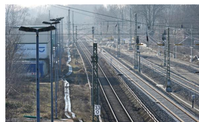
Blick auf die Gleise am Bahnhof Zossen in Richtung des Bahnübergangs „Oertelufer“ (Februar 2025) [Quelle: PUS GmbH]
