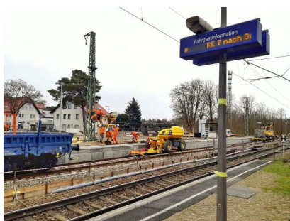
An den durchgehenden Hauptgleisen im Bahnhof Wünsdorf-Waldstadt werden wir zwei Außenbahnsteige mit einer Breite von vier Metern errichten (Februar 2022) [Quelle: DB Netz AG]
