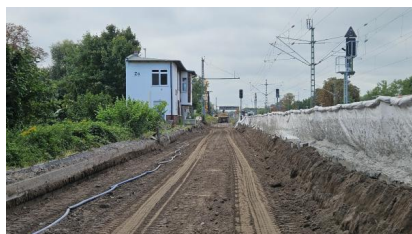
Blick auf den Fortschritt der Arbeiten für den Neubau von Gleis 2 am Bahnhof Zossen (August 2025) [Quelle: PUS GmbH]
