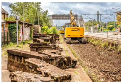
Rückbauarbeiten am Hausbahnsteig am Bahnhof Zossen (August 2025) [Quelle: PUS GmbH]
