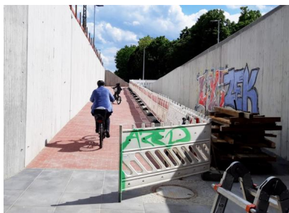
Die Rampe im Bahnhof Wünsdorf-Waldstadt kann seit dem 31. Mai 2022 befahren werden. Der bauzeitliche Personenaufzug wurde entfernt (Mai 2022) [Quelle: DB Netz AG]
