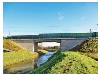
Die Lärmschutzwand in Großhain wurde Ende 2021 fertiggestellt (Dezember 2021) [Quelle: DB Netz AG]
