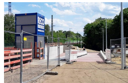
Die Rampe im Bahnhof Wünsdorf-Waldstadt kann seit dem 31. Mai 2022 befahren werden. Der bauzeitliche Personenaufzug wurde entfernt (Mai 2022) [Quelle: DB Netz AG]
