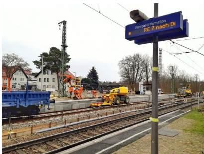
An den durchgehenden Hauptgleisen im Bahnhof Wünsdorf-Waldstadt werden wir zwei Außenbahnsteige mit einer Breite von vier Metern errichten (Februar 2022) [Quelle: DB Netz AG]
