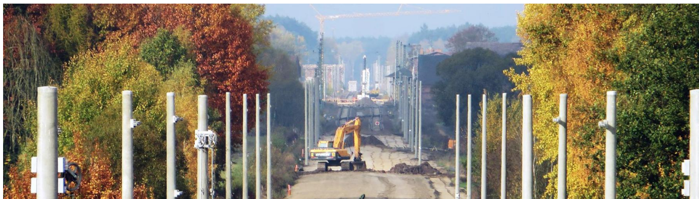
Streckenausbau im Los Nord (November 2016) [Quelle: DB Netz AG]
