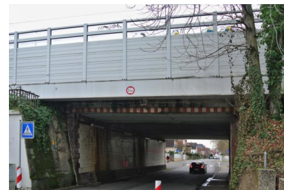
Blick auf die Ostseite der Brücke (Januar 2021) [Quelle: Deutsche Bahn AG/Florian Sollich]
