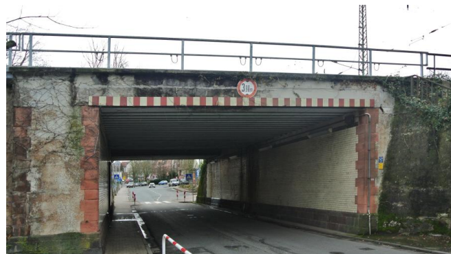
Blick auf die Westseite der Brücke (Januar 2021) [Quelle: Deutsche Bahn AG/Florian Solllich]
