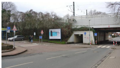
Blick auf die Ostseite der Brücke (Januar 2021) [Quelle: Deutsche Bahn AG/Florian Sollich]
