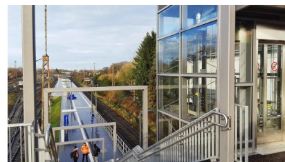
Die Station Bremerhaven-Wulsdorf wurde bereits modernisiert und barrierefrei ausgebaut (Dezember 2020) [Quelle: DB Station&Service AG]
