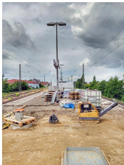
Blick auf die Arbeiten am Bahnsteig des Bahnhofs Bremen-Oslebshausen (Juli 2023) [Quelle: DB Station&Service AG]
