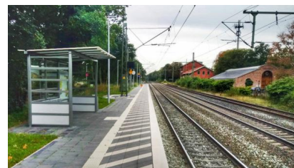
Die Station Bremen-Oberneuland wurde bereits modernisiert und barrierefrei ausgebaut (Oktober 2021) [Quelle: DB Station&Service AG]
