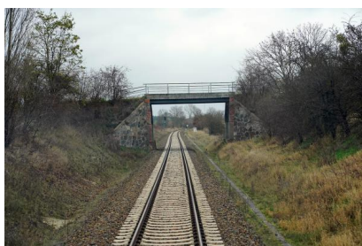
Blick auf einen Teil der Strecke. Bis 2025 wird diese modernisiert und durchgehend zweigleisig für Geschwindigkeiten bis 160 km/h ausgebaut (November 2021) [Quelle: Deutsche Bahn AG/Volker Emersleben]
