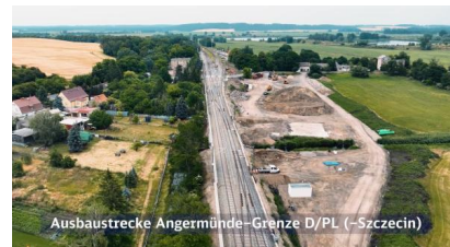
YouTube: Baustellenbesuch mit dem Projektleiter (Dezember 2023) [Quelle: DB Netz AG]
