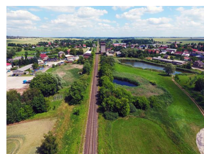
Streckenabschnitt Passow – Grenze (D/PL) bei Casekow: Entlang des 30 Kilometer langen Abschnitts ist der Neubau eines zweiten Gleises sowie der Oberleitung vorgesehen (Juni 2016) [Quelle: IVD Ingenieur- und Vermessungsbüro Dimitrov]
