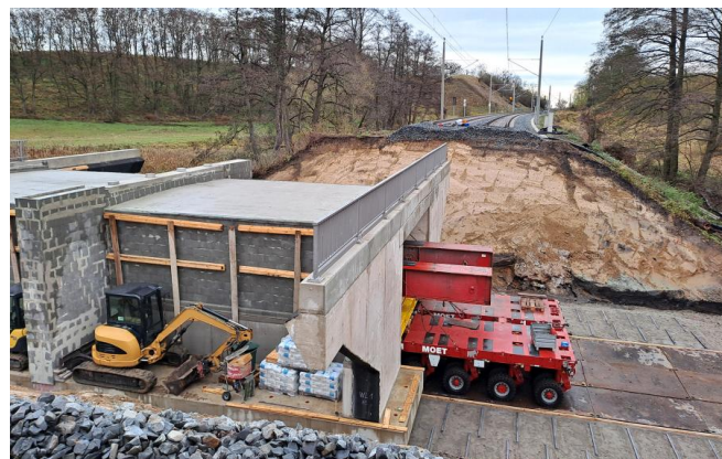
Die neue Stahlbetonrahmenbrücke wurde am 15. November 2025 mit Hilfe eines Schwerlasttransporters eingefahren (November 2025) [Quelle: DB InfraGO AG]
