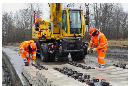
Am 30. November 2021 wurde mit dem Ausbau des 1. Bauabschnitts Angermünde – Passow begonnen (November 2021) [Quelle: Deutsche Bahn AG/Volker Emersleben]
