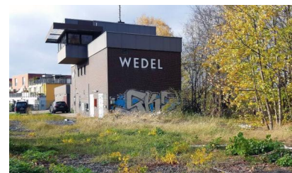
Blick auf die Stromversorgungsstation mit Gleichrichterwerk in Wedel (November 2021) [Quelle: DB Energie GmbH]
