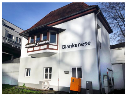
Das Elektromechanische Stellwerk in Hamburg-Blankenese (Februar 2020) [Quelle: DB Netz AG]
