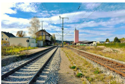
Wir verlängern im Bahnhof Tannheim (Württ) die Gleise 1 und 2 in Richtung Osten auf eine Nutzlänge von 740 Metern (November 2022) [Quelle: DB Netz AG/Michael Waag]
