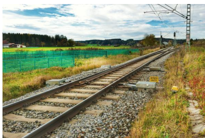
In Tannheim (Württ) führen wir eine signaltechnische Einbindung in das bestehende Elektronische Stellwerk sowie eine Anpassung der Oberleitung durch (November 2022) [Quelle: DB Netz AG/Michael Waag]
