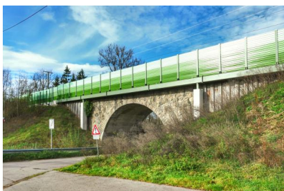
Wir erweitern die eingleisige Eisenbahnüberführung „Hopfenstraße“ in Buxheim um ein zweites Gleis (November 2022) [Quelle: DB Netz AG/Michael Waag]
