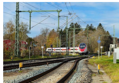
Wir passen im Bahnhof Kißlegg unter anderem die Oberleitung an (November 2022) [Quelle: DB Netz AG/Michael Waag]
