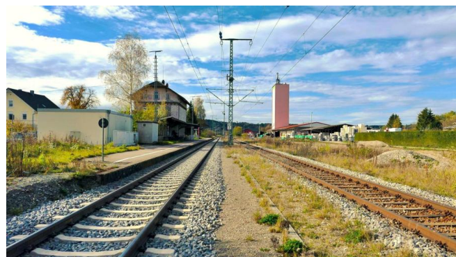
Wir verlängern im Bahnhof Tannheim (Württ) die Gleise 1 und 2 in Richtung Osten auf eine Nutzlänge von 740 Metern (November 2022) [Quelle: DB Netz AG/Michael Waag]
