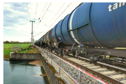
In Tannheim (Württ) erweitern wir die Eisenbahnüberführung über den Illerkanal um ein zweites Gleis (November 2022) [Quelle: DB Netz AG/Michael Waag]
