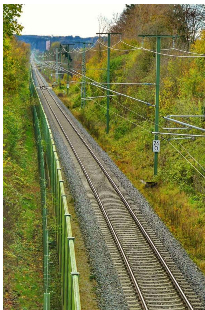
In Buxheim passen wir unter anderem die Oberleitung an und bauen nördlich des Gleises ein zusätzliches Überhol- und Kreuzungsgleis für Güterzüge mit einer Nutzlänge von 740 Metern (November 2022) [Quelle: DB Netz AG/Michael Waag]
