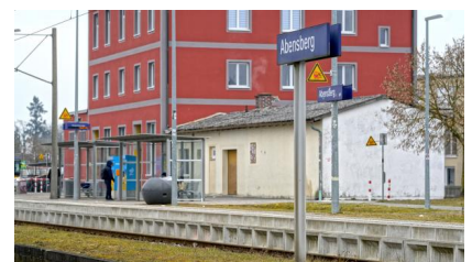
Bestandsaufnahme der Bahnsteige und des Empfangsgebäudes vor dem Umbau (Februar 2025) [Quelle: Deutsche Bahn AG/Christian Bedeschinski]
