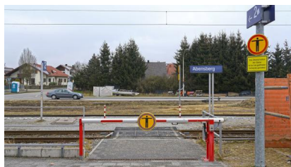
Personenüberführung mit Schranke von Bahnsteig 1 zu Bahnsteig 2 (Februar 2025) [Quelle: Deutsche Bahn AG/Christian Bedeschinski]
