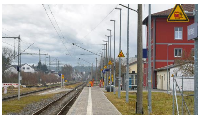
Bestandsaufnahme der Bahnsteige und des Empfangsgebäudes vor dem Umbau (Februar 2025) [Quelle: Deutsche Bahn AG/Christian Bedeschinski]
