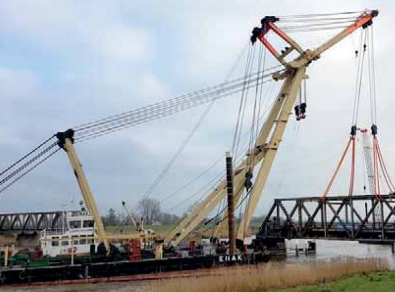
Aushub des ersten Brückenüberbaus
