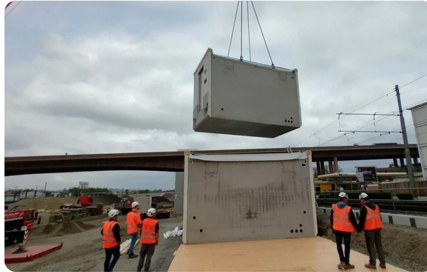
Aufstellen eines GFK-Moduls /Quelle: Deutsche Bahn AG
