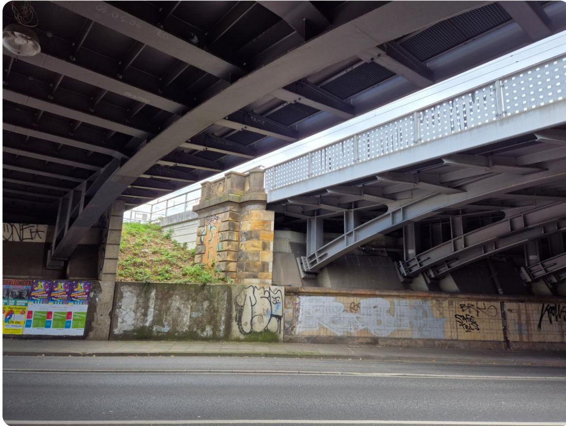
Bestandsbauwerk Eisenbahnüberführung Schiffgraben / Quelle: DB InfraGO AG
