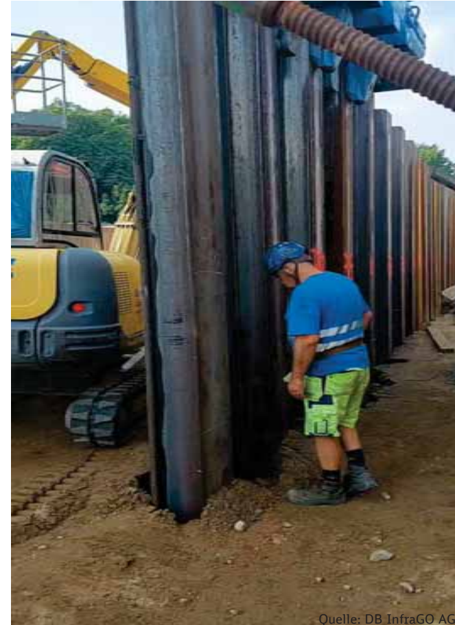
Planfestgestellte Variante Pressen der Spundbohlen
