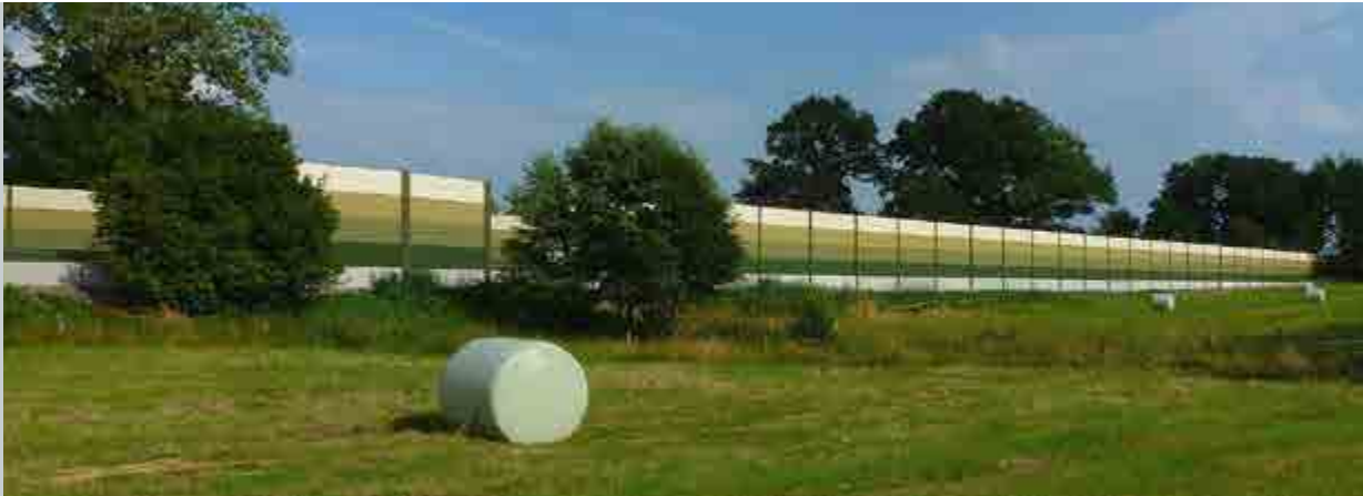
Bau einer Schallschutzwand (Beispielbild)
