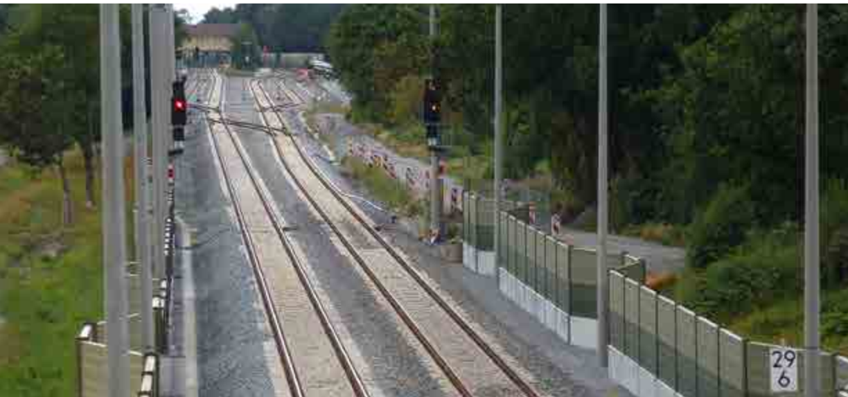
Der Streckenabschnitt zwischen Rastede und Varel ist seit 2012 durchgehend zweigleisig ausgebaut.
