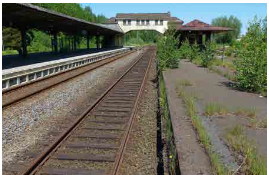
Bahnhof Sande mit Bahnsteigbrücke
