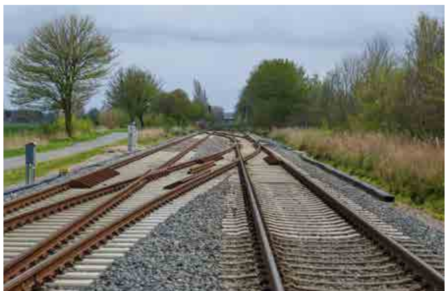
Überleitverbindung „Schwarzer Rabe“: Diese Weichen ermöglichen den bauzeitlichen Gleiswechsel für Personen- und Güterzüge.
