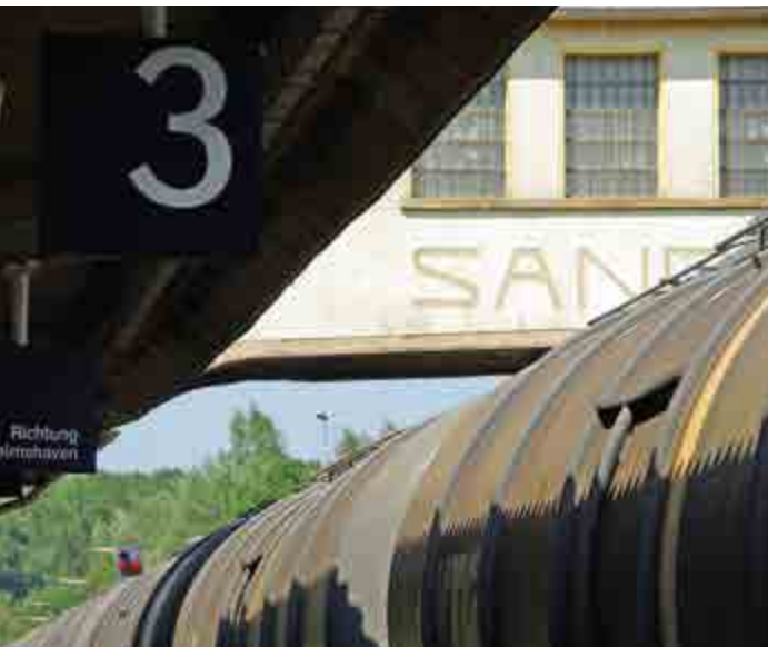
Die denkmalgeschützte Bahnsteigbrücke im Bahnhof Sande, gebaut Anfang des 20. Jahrhunderts, ist zu niedrig für die geplante Oberleitung. Da die Bausubstanz ein Anheben der Brücke nicht zulässt, muss sie zurückgebaut werden.
