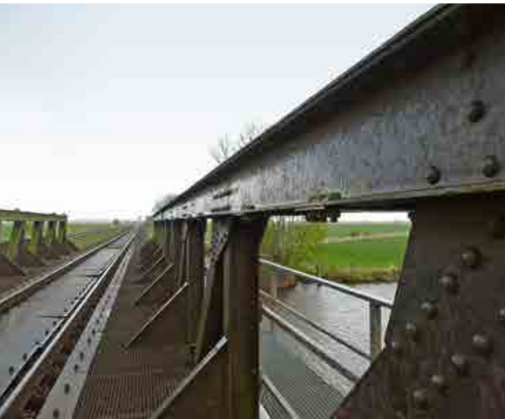
Die vorhandene Stahlbrücke - im rechten Gleis mit einem Stahlfachwerkträger von 1907 - über das Ellenserdammer Tief wird durch einen Neubau ersetzt.
