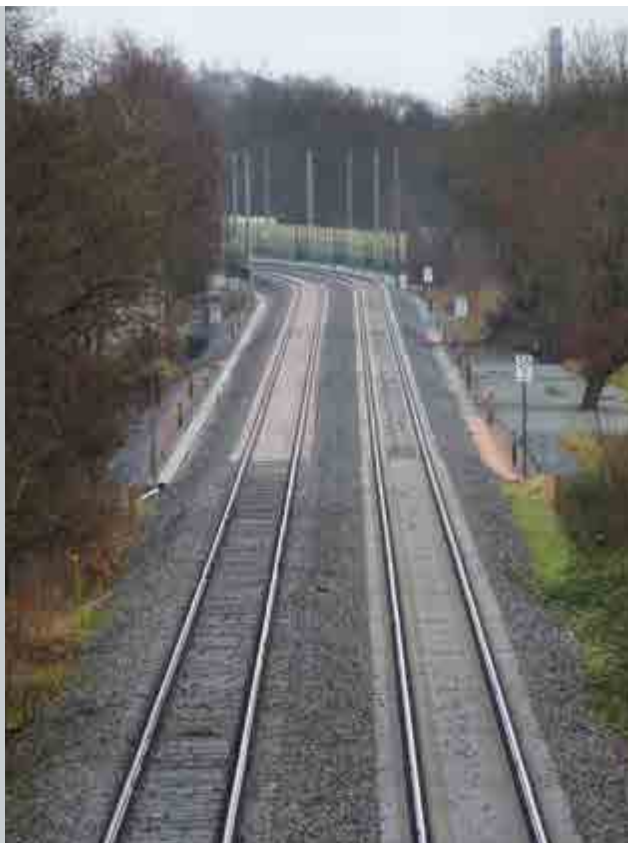
Der PFA 4 beginnt bei Bahnkilometer 35,2. Im Hintergrund: Der bereits fertiggestellte Abschnitt 3 mit neuem Oberbau, Lärmschutzwänden und Oberleitungsmasten im Bereich Varel-Dangastermoor. Die eigentliche Oberleitung ist dort noch nicht montiert.
