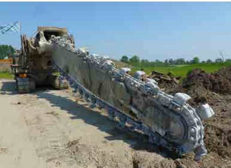
Maschine für das Fräs-Misch-Injektionsverfahren in einer Einsatzpause südlich von Varel (2012)
