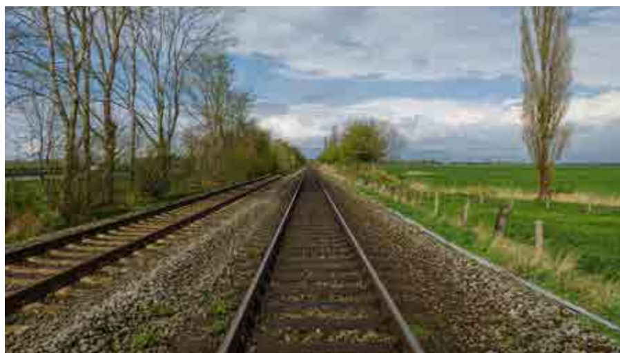
Der alte Oberbau der Bahnstrecke wird vollständig erneuert, so auch hier zwischen der Autobahn A 29 und dem fast baumfreien Marschland.
