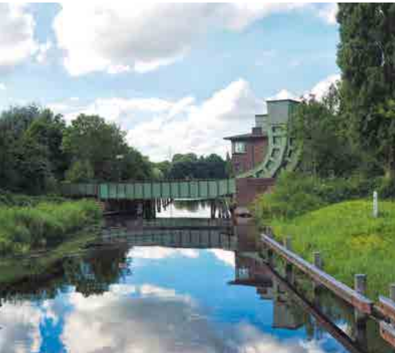
Denkmalgeschützte Eisenbahnüberführung Ems-Jade-Kanal
