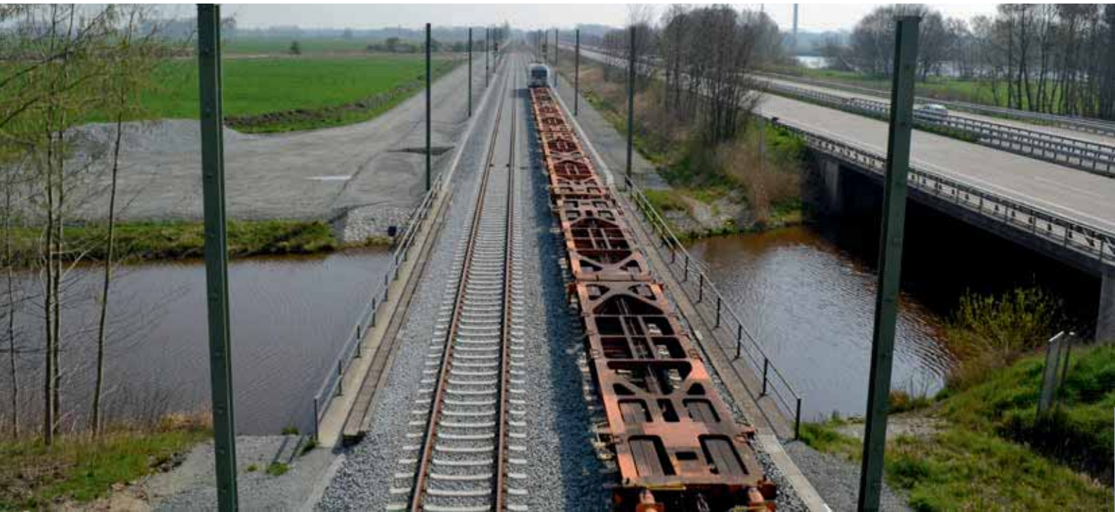
Die bereits fertiggestellte Bahnstrecke über das Steinhauser Tief entlang der Autobahn 29.
