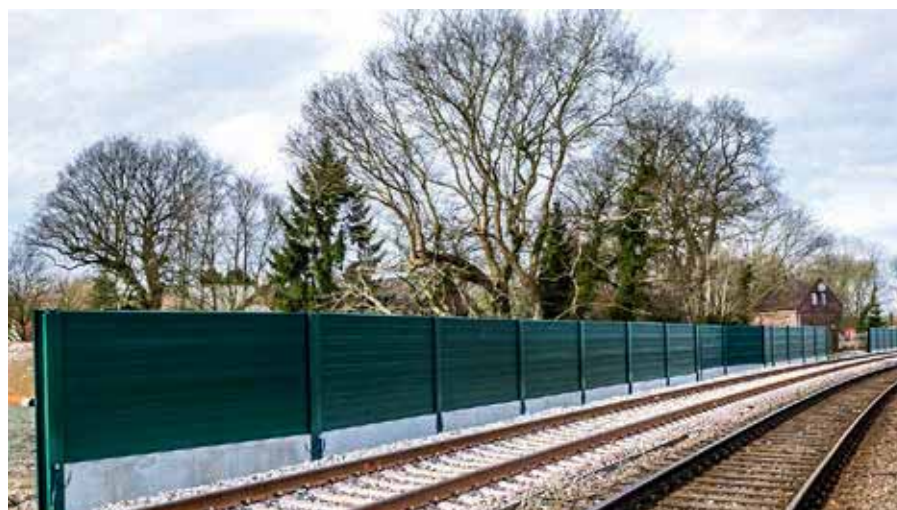
Lärmschutzwand in der Ortschaft Ellenserdammersiel (zwischen Varel und Sande)
