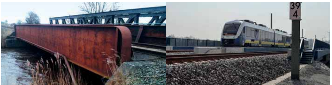
Die vorhandene Eisenbahnbrücke über das Ellenserdammer Tief entsprach nicht den Streckenanforderungen und wurde durch ein neues, auf Bohrpfehlen tiefgegründetes Bauwerk an gleicher Stelle ersetzt. Links: Die Stahlbrücke von 1907. Rechts: Die neue Brücke in Betrieb.
