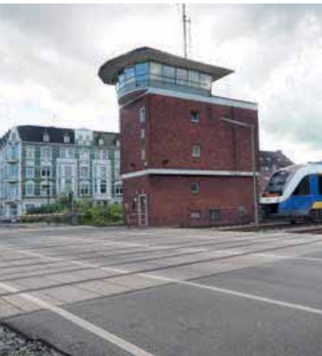
Altes Relaisstellwerk am Bahnübergang Luisenstraße
