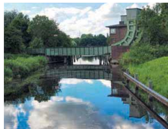
Denkmalgeschützte Eisenbahnüberführung Ems-Jade-Kanal
