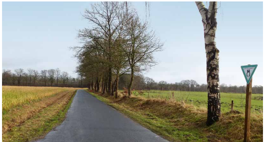
Sanierungsbedürftige Wallhecke im Landkreis Ammerland.
