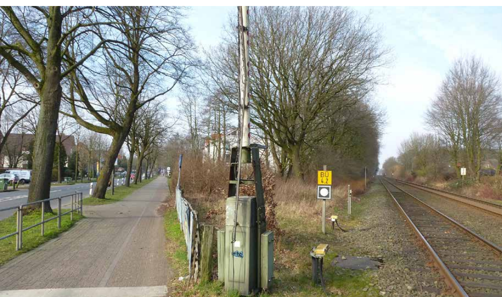
Heutiger Zustand im Bereich des Bahnübergangs Alexanderstraße.
