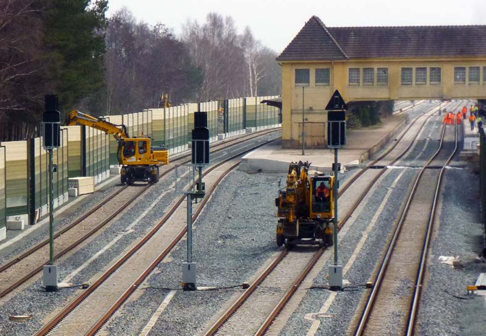
Neue Gleise im Bereich der Bahnsteigbrücke in Varel
