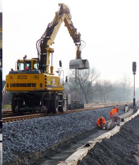
Bauarbeiten in Jaderberg
