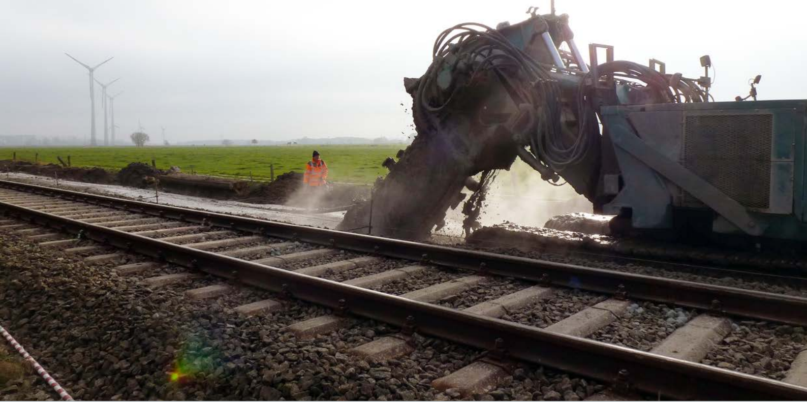
Die Fräse des FMI-Verfahrens im Einsatz in der Nähe von Varel-Streek
