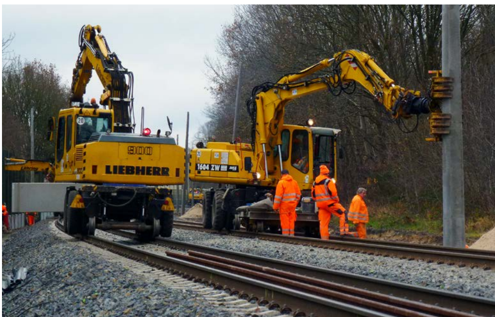
Setzen der Oberleitungsmasten in Hahn-Lehmden
