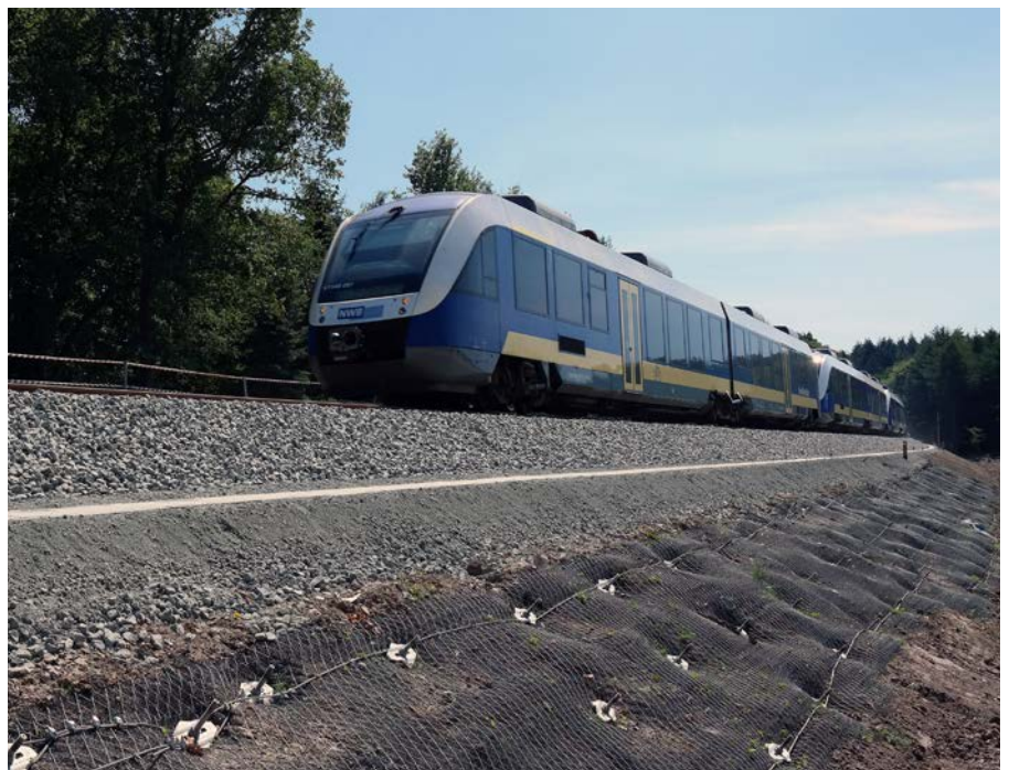
Böschungsvernagelung im Bereich Rastede-Bekhausen
