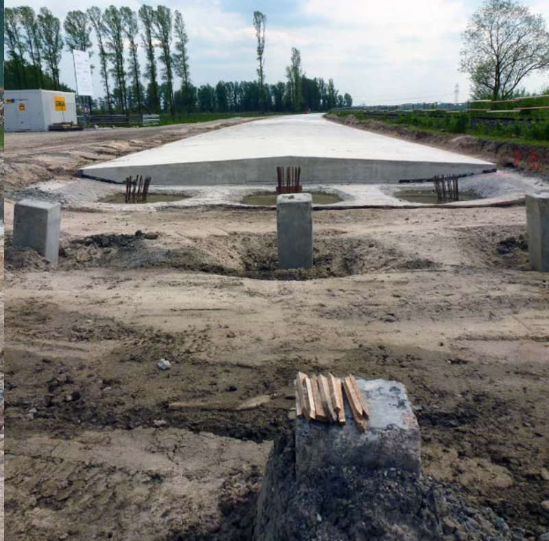
... fertiggestellte Stahlbetonplatte, auf der anschließend Schotter und Gleise verlegt werden.
