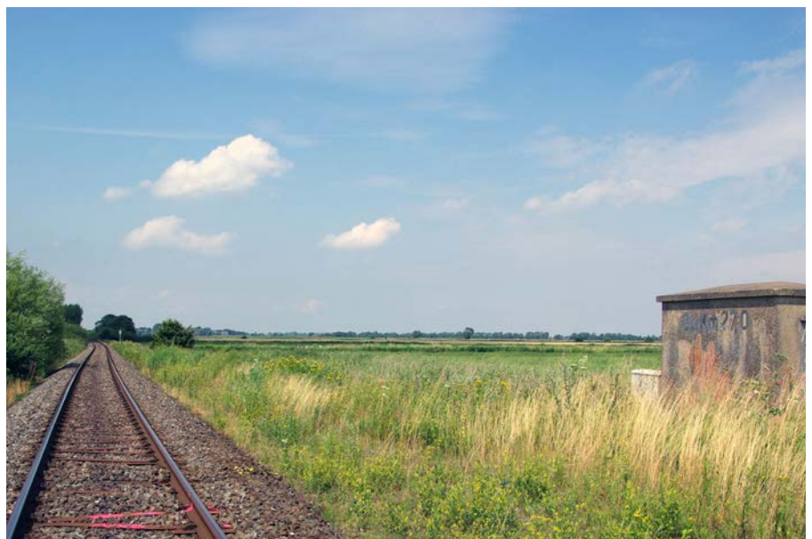
Eingleisiger Streckenabschnitt am Vogelschutzgebiet „Marschen am Jadebusen“ vor Beginn der Ausbaumaßnahme.
