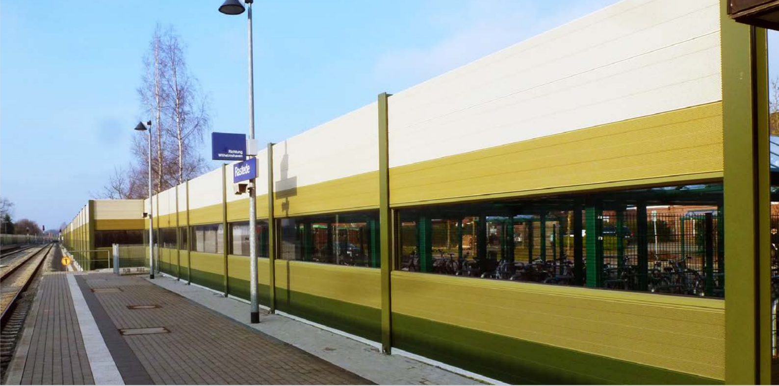
In Einzelfällen, wie beispielsweise am Bahnhof Rastede, sind Wandelemente aus Glas eingesetzt.
