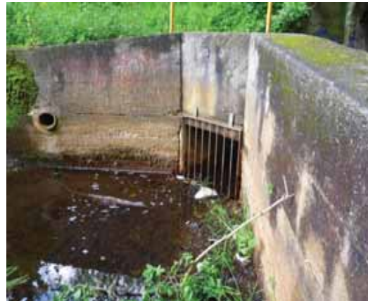
km 101,900 bahnlinks Durchlass, Zwei Stahlrohre DN 900
