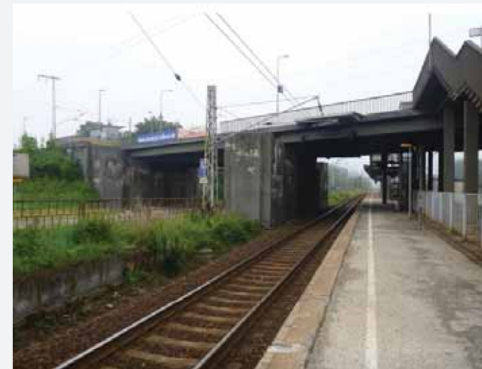
Eisenbahnüberführung L60 (Bahn-km 102,925)
