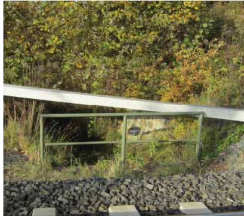
km 99,820 bahnrechts Durchlass, neuer Durchlass in der Größe DN 600
