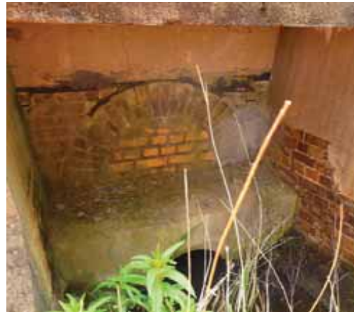
km 100,221 bahnlinks Durchlass, neuer Durchlass in der Größe DN 600
