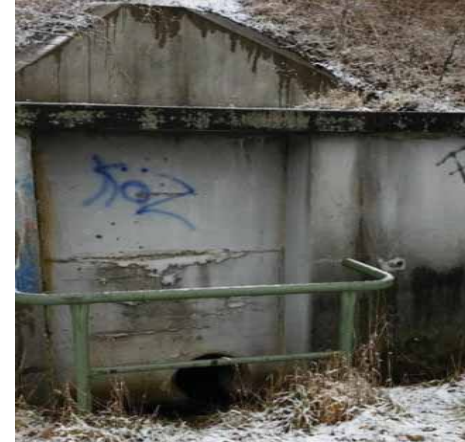
km 101,685 bahnlinks Durchlass, drei Schachtbauwerke DN 1200
