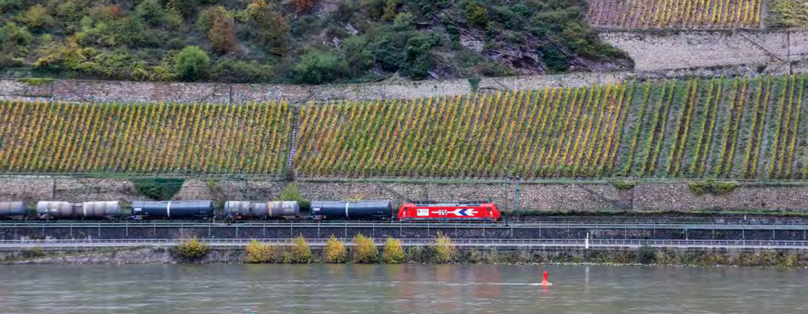
Die Strecken im Rheintal sind Teil des wichtigsten europäischen Nord-Süd-Korridors für den Güterfernverkehr.
