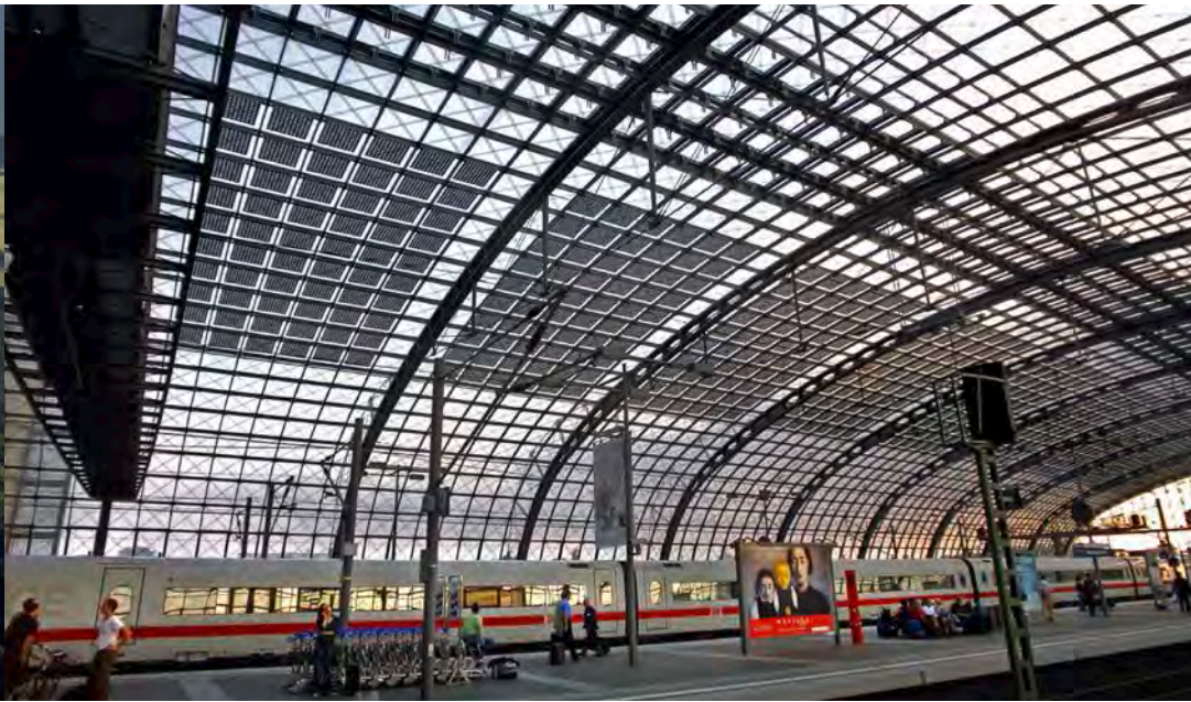
Photovoltaik auf dem Dach des Berliner Hauptbahnhofs
