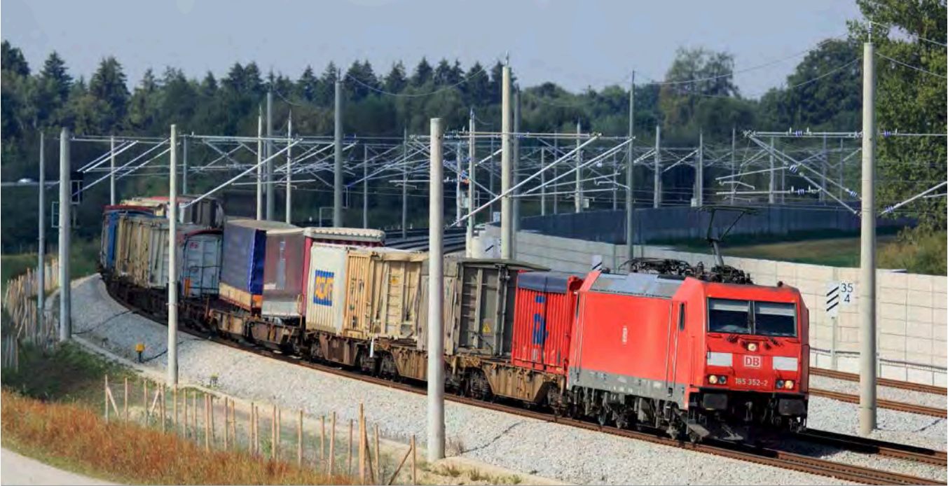
Schallschutzwand bei Hattenhofen
