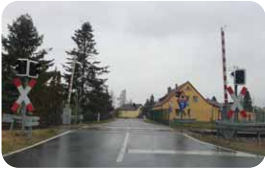
(Quelle: DB Netz AG)
