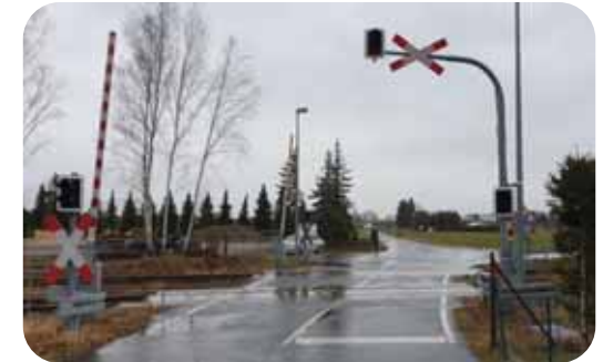
(Quelle: DB Netz AG)
