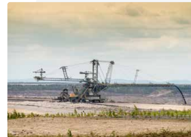
Absetzer zur Schüttung der obersten Erdschichten im Tagebau Reichwalde
