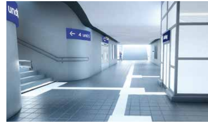
Die neue hellbeleuchtete Personenunterführung mit Aufzügen.
