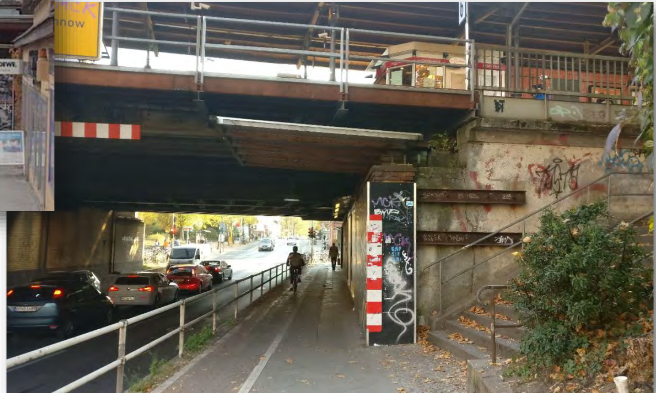
Böschungstreppe auf der Nordwestseite
