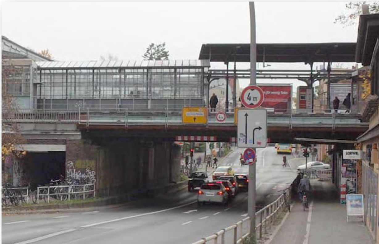
Brücken über den Teltower Damm
