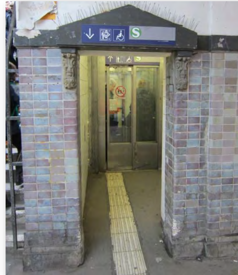
Zugangssituation zum Aufzug
