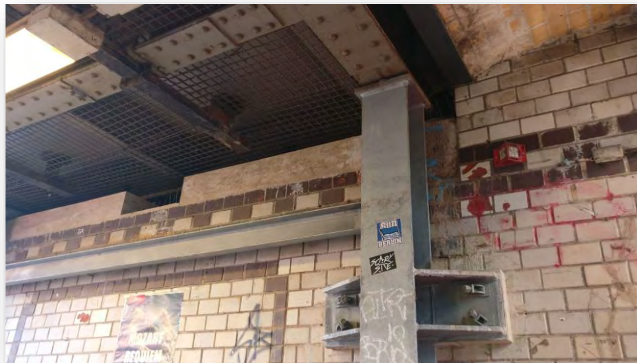
Zusätzliche Stützung des Brückenüberbaus
