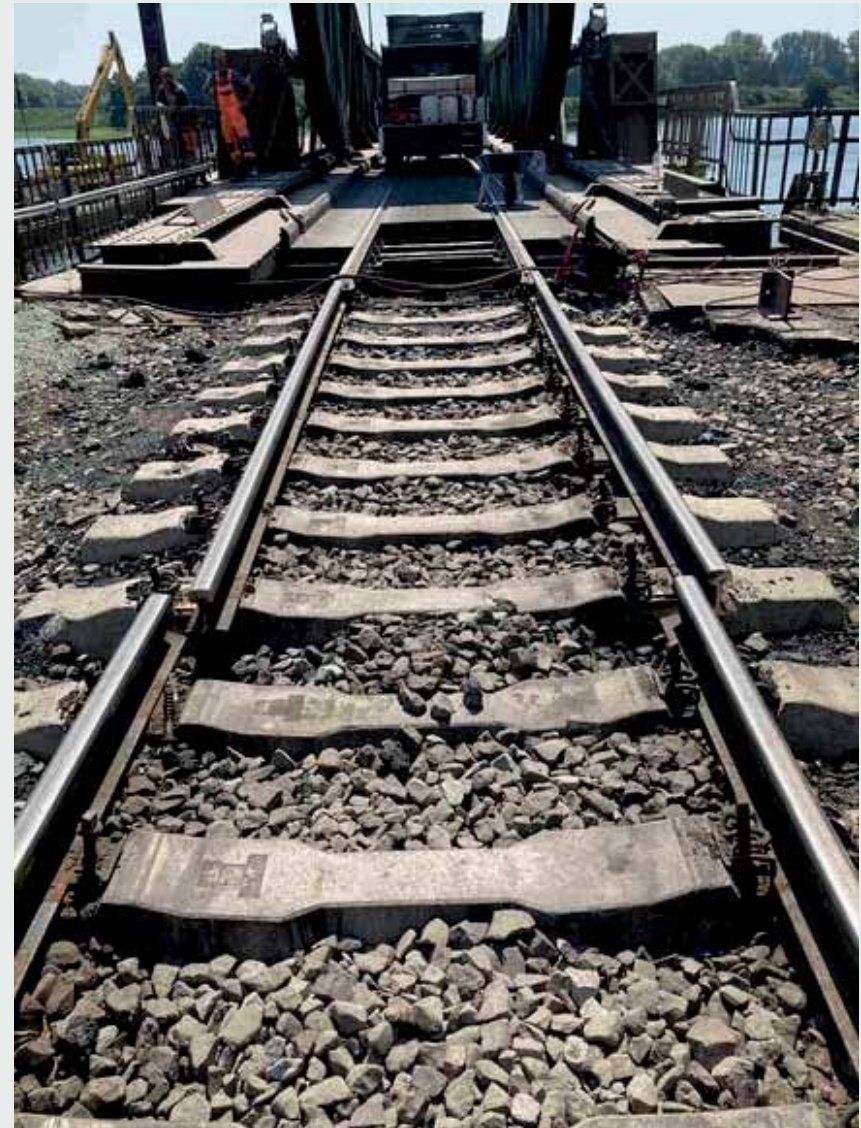
Bestandsbrücke, Gleislage nach Trennen der Schienen Quelle: DB Netz AG
