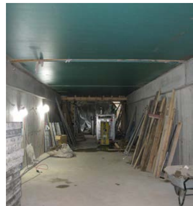
Blick in den Rohbau des Tunnel mit Dickblech als Decke
