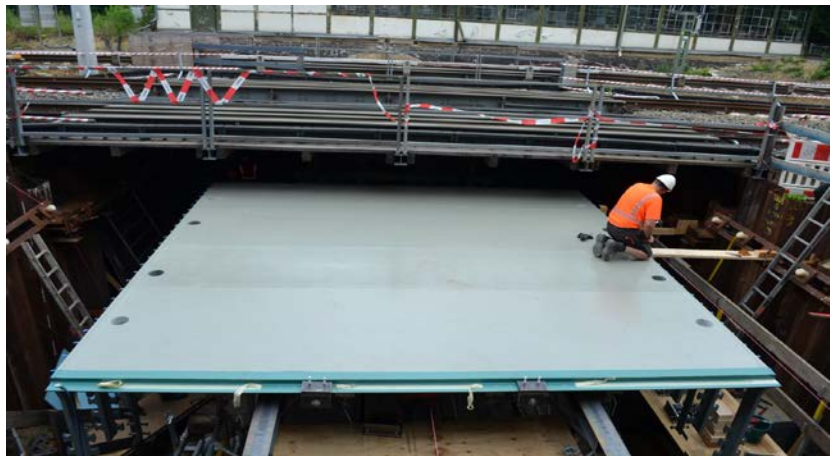
Einbau der ersten drei Dickbleche im Juni
