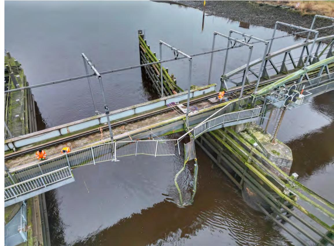
Blick auf die beschädigte Brücke nach dem Schiffsanprall (Februar 2024)
