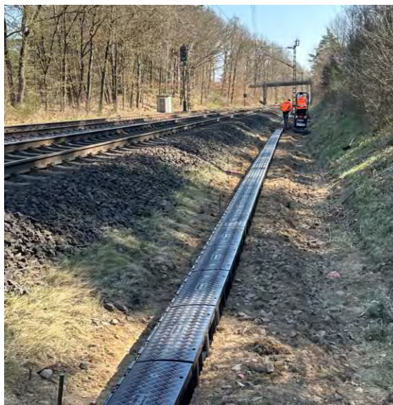
Bau von Kabelkanälen während des Zugbetriebs
