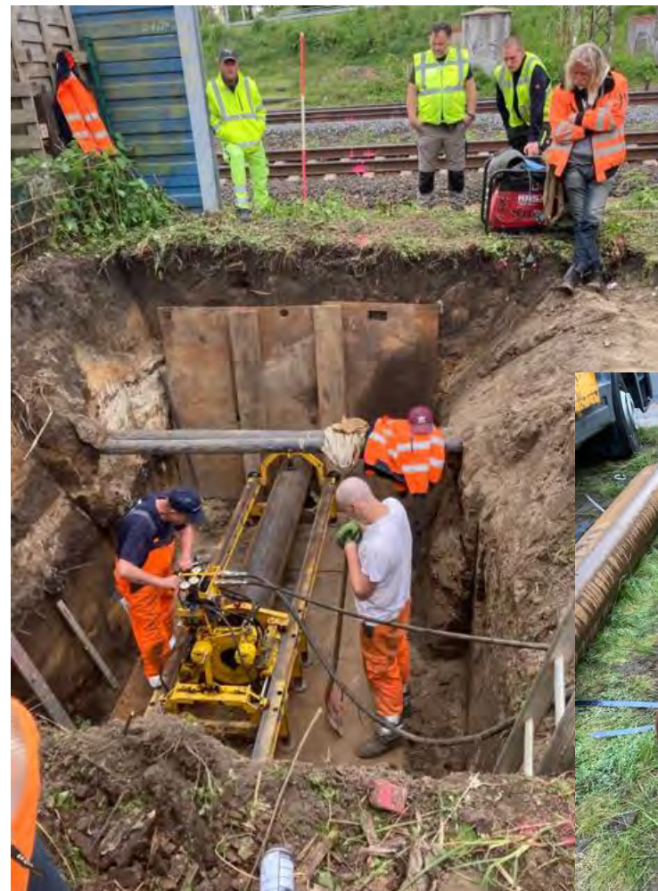
Herstellung von Gleisquerungen in geschlossener Bauweise
