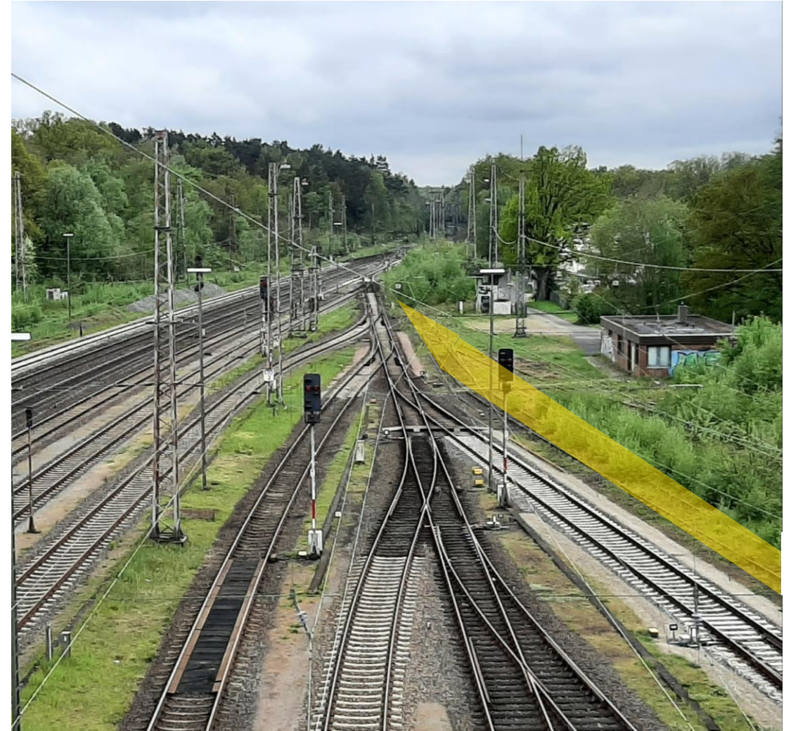
Strecke 1720 – km 130,3, Richtung Süden
