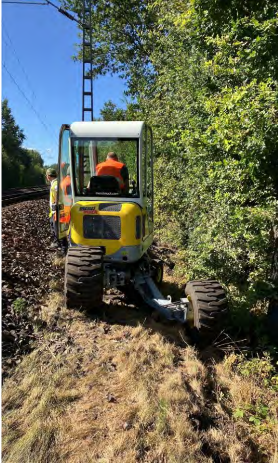
Flexibles Arbeiten im Böschungsbereich durch Schreitbagger
