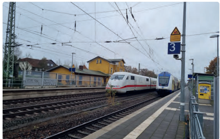
Während Sperrpause der Qualitätsoffensive: Umsetzung der Modernisierungsmaßnahmen auf den Bahnsteigen, neue Zuwegung zu den Aufzügen und Aufzugsneubau als nachlaufende Maßnahmen. Abschluss bis voraussichtlich Ende 2026.
