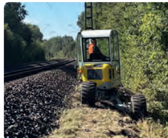
Flexibles Arbeiten im Böschungsbereich durch Schreitbagger
