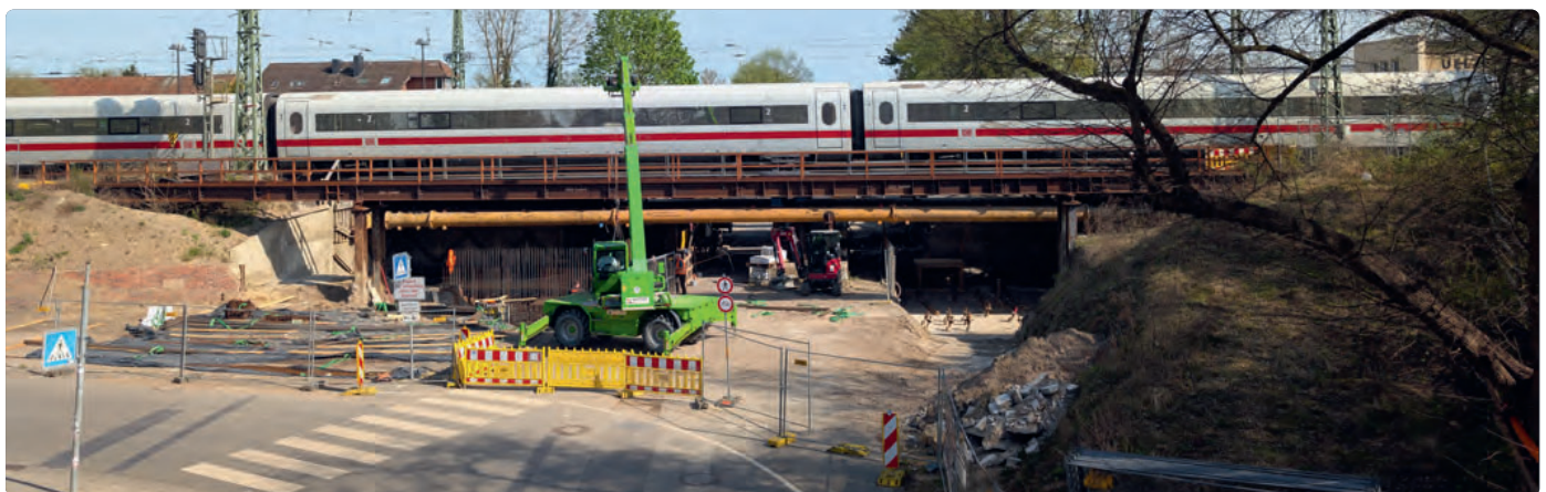
Trotz der stattfindenden Bauarbeiten an der Brücke lief der Zugverkehr bisher immer weiter. Während der Qualitätsoffensive 2026 fahren keine Züge. Hierdurch sind wir in der Lage, die Übergangsbrücken herauszunehmen und die neuen, finalen Brückenelement fest zu verbauen.
