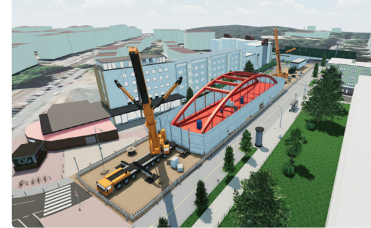
Die Brücke wird auf einer Fläche am Riedhofkreisel vor den Häusern Mörfelder Landstraße 235 – 247 vormontiert.
