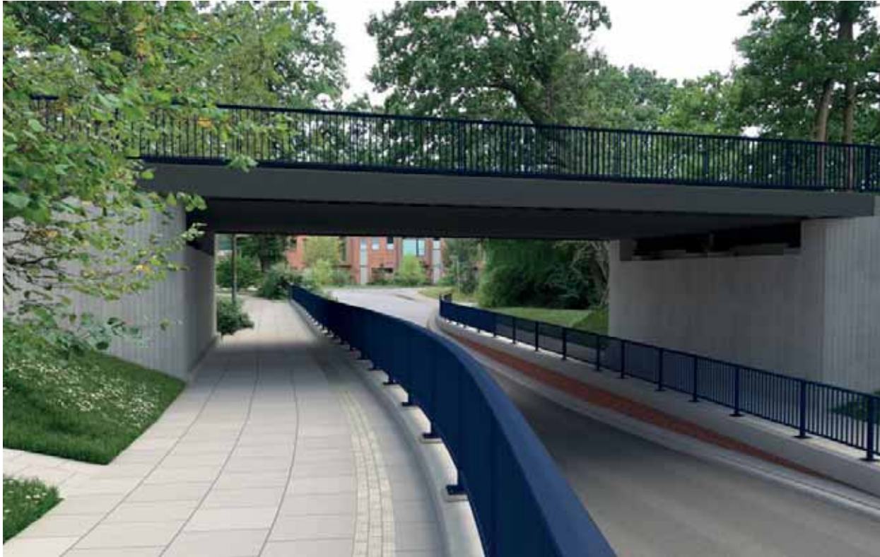
EÜ Sodenkamp Ansicht von Norden
