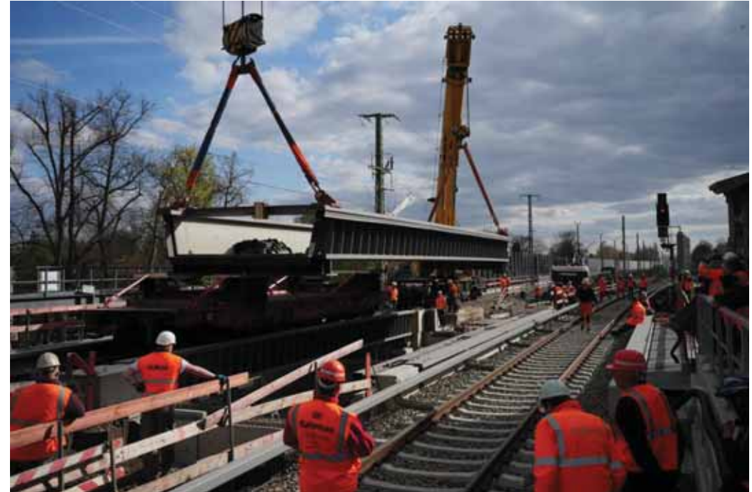
Brückeneinhub am S-Bahnhof Karow im April 2021. (Quelle: DB Netz AG)
