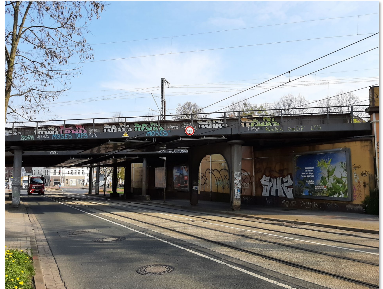
Foto: Ansicht EÜ Schulenburger Landstraße Südseite (Quelle: DB InfraGo AG)
