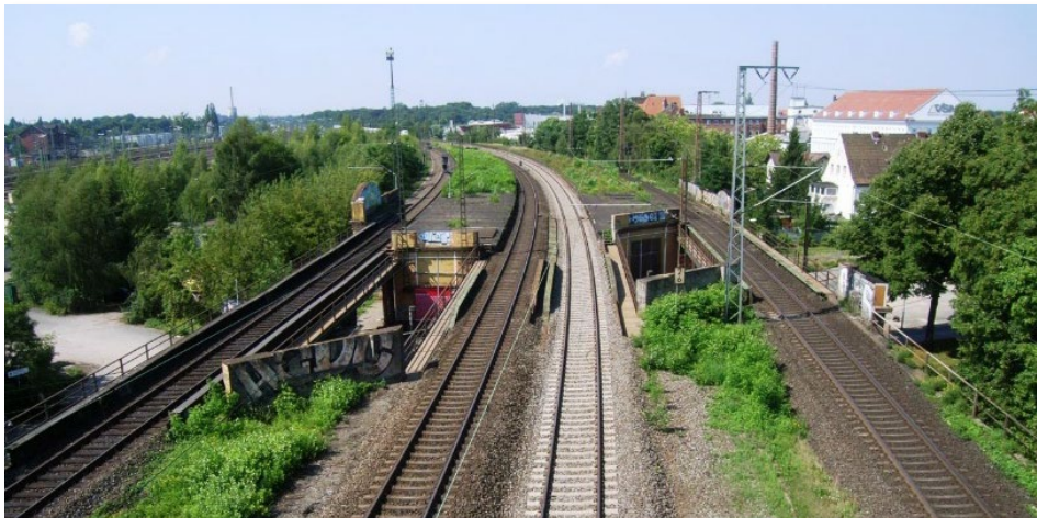
Foto: Draufsicht EÜ SBL (Quelle: DB InfraGo AG)
