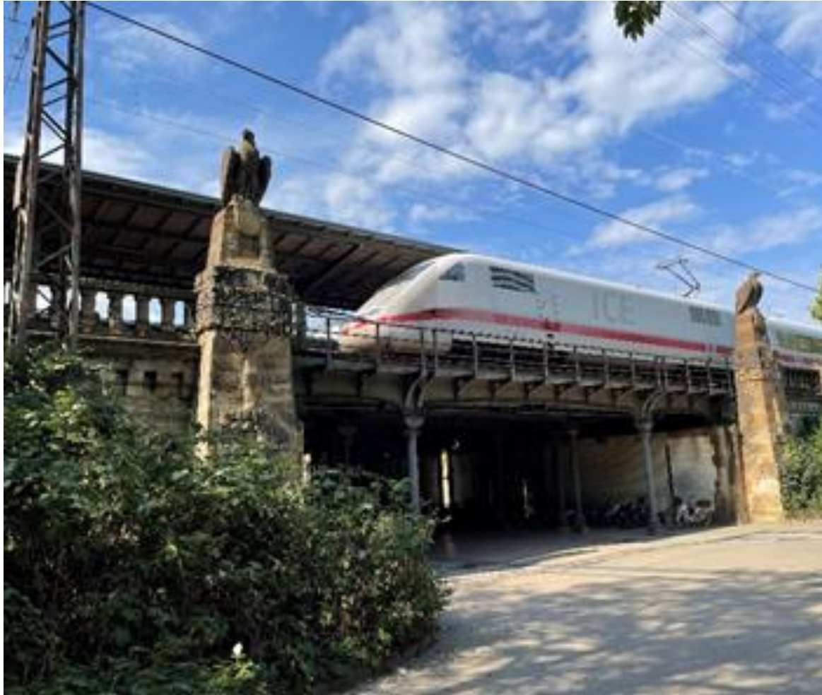
Abbildung: EÜ Bismarckstraße Ansicht Westseite (Quelle: DB InfraGO)
