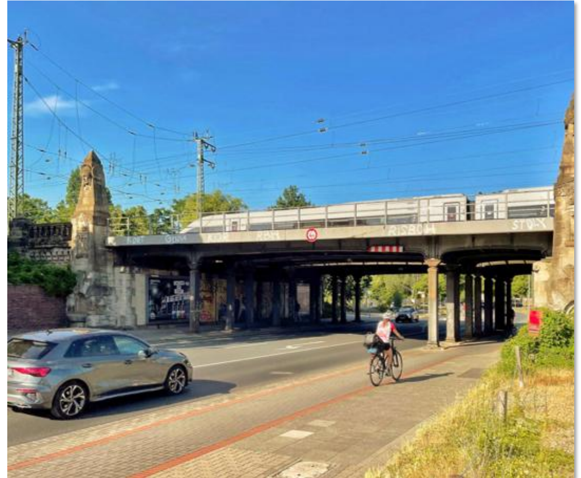
Abbildung: EÜ Altenbekener Damm Ansicht Westseite (Quelle: DB InfraGO)
