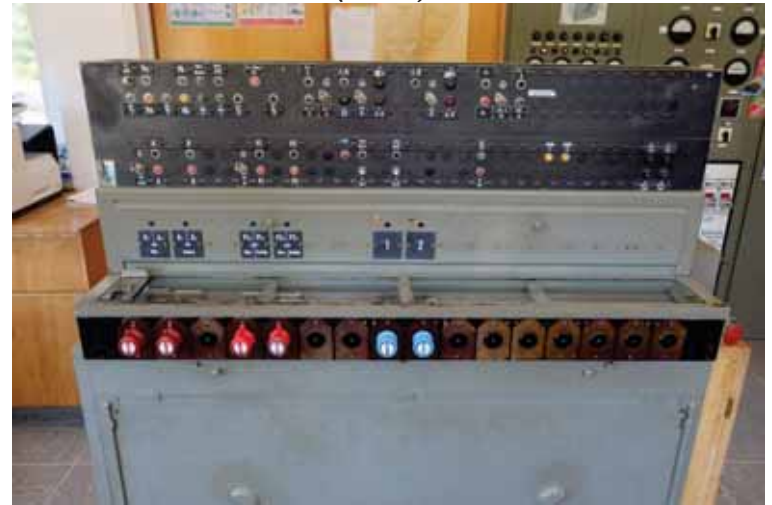
Bestehendes Stellwerk Tönning
