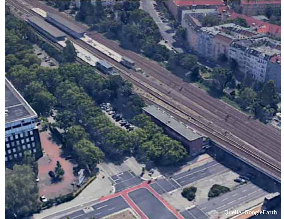
Verkehrsstation Jungfernheide mit Gleichrichterunterwerk (GUw)
